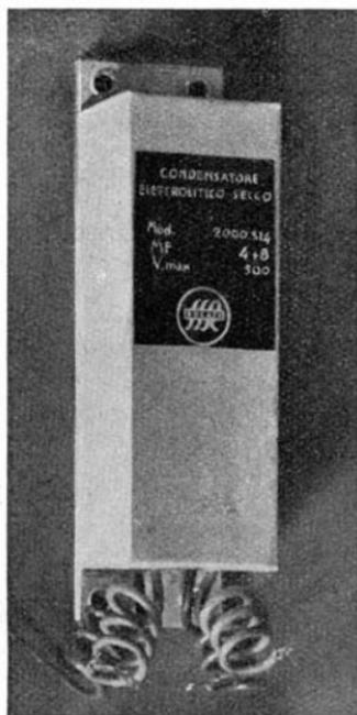
Fig. 106. - Esempio di condensatore elettrolitico a secco, in custodia di cellulosa.
