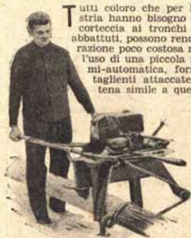
La macchina che toglie con poca spesa la corteccia ai tronchi.
