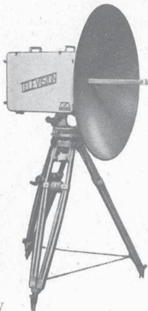
Il « ponte radio », o cavo hertziano, comprende un trasmettitore-ricevitore lavorante su onde centimetriche. Tali onde vengono facilmente dirette a fascio mediante riflettori. Qui un complesso della Comp. des Compleurs.
