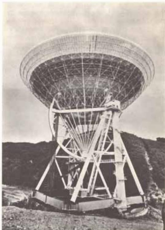
*Il radiotelescoio di Effelberg (Bonn). Paraboloido completamente orientabile da 100 m, completato nel 1971, è il più grande nel mondo nel suo genere, ed è l'unico che superi il MKI di Jodrell Bank.*
