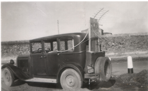
Santa Marinella – Via Aurelia la mitica Balilla a 3 marce usata da Marconi per gli esperimenti di Radiotelefonica Mobile a microonde (sul retro dell'auto è montata l'antenna parabolica)
