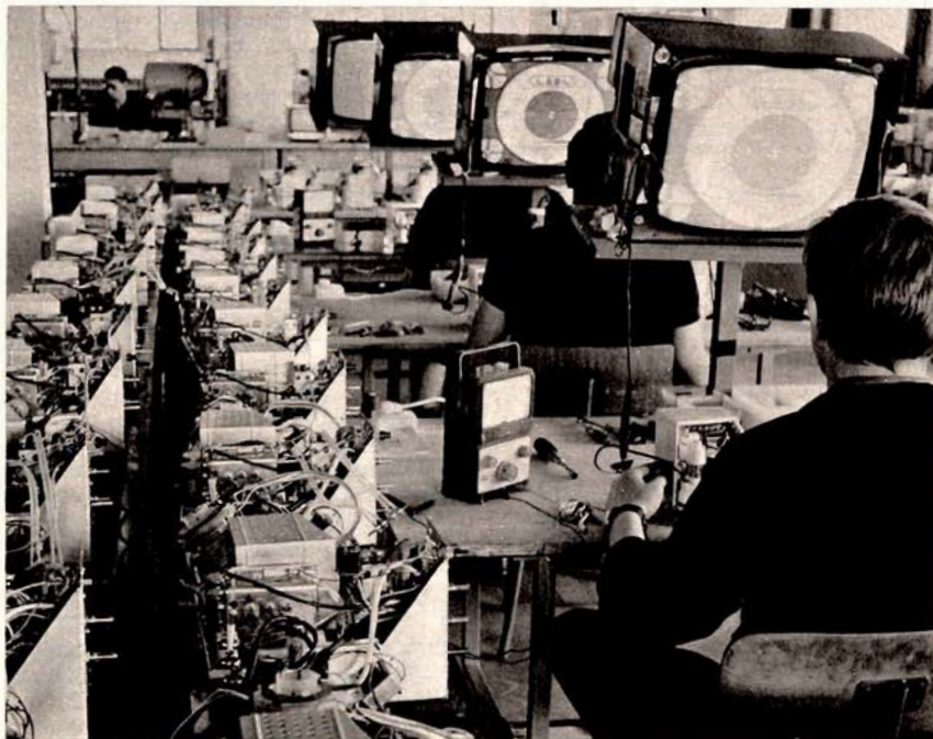
Il controllo degli apparecchi è meticoloso e rigidissimo: tutti i televisori vengono provati uno a uno prima di essere avviati alla spedizione.
