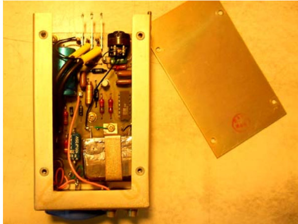
22) La piastra è stata rimessa all'interno del modulo.
