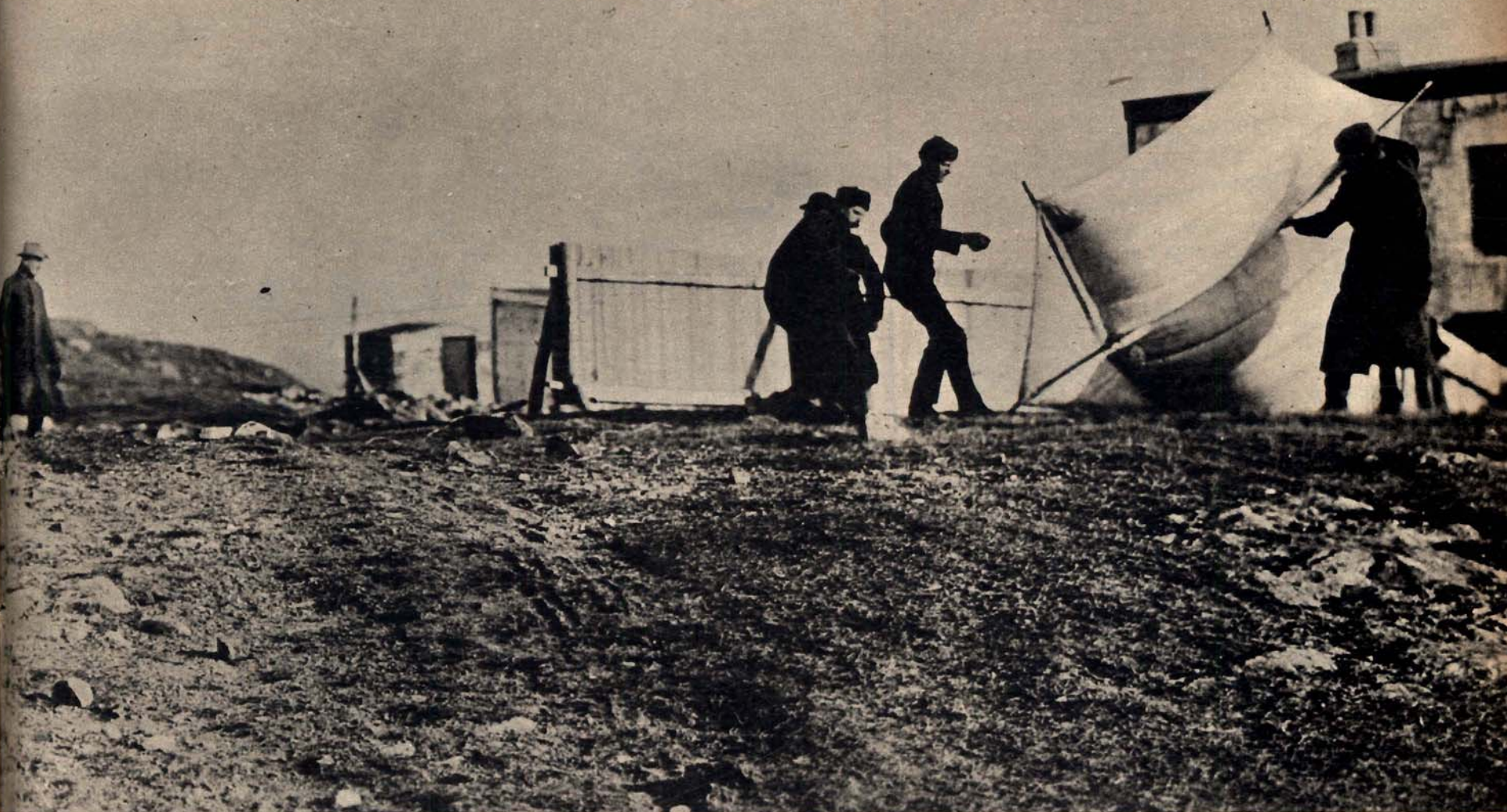
I DUE ASSISTENTI INGLESI DI MARCONI ALZANO L'AQUILONE CHE SOSTERRA L'AEREO ALTO 150 METRI. DUE PRECEDENTI TENTATIVI FURONO STRONCATI DAL VENTO
