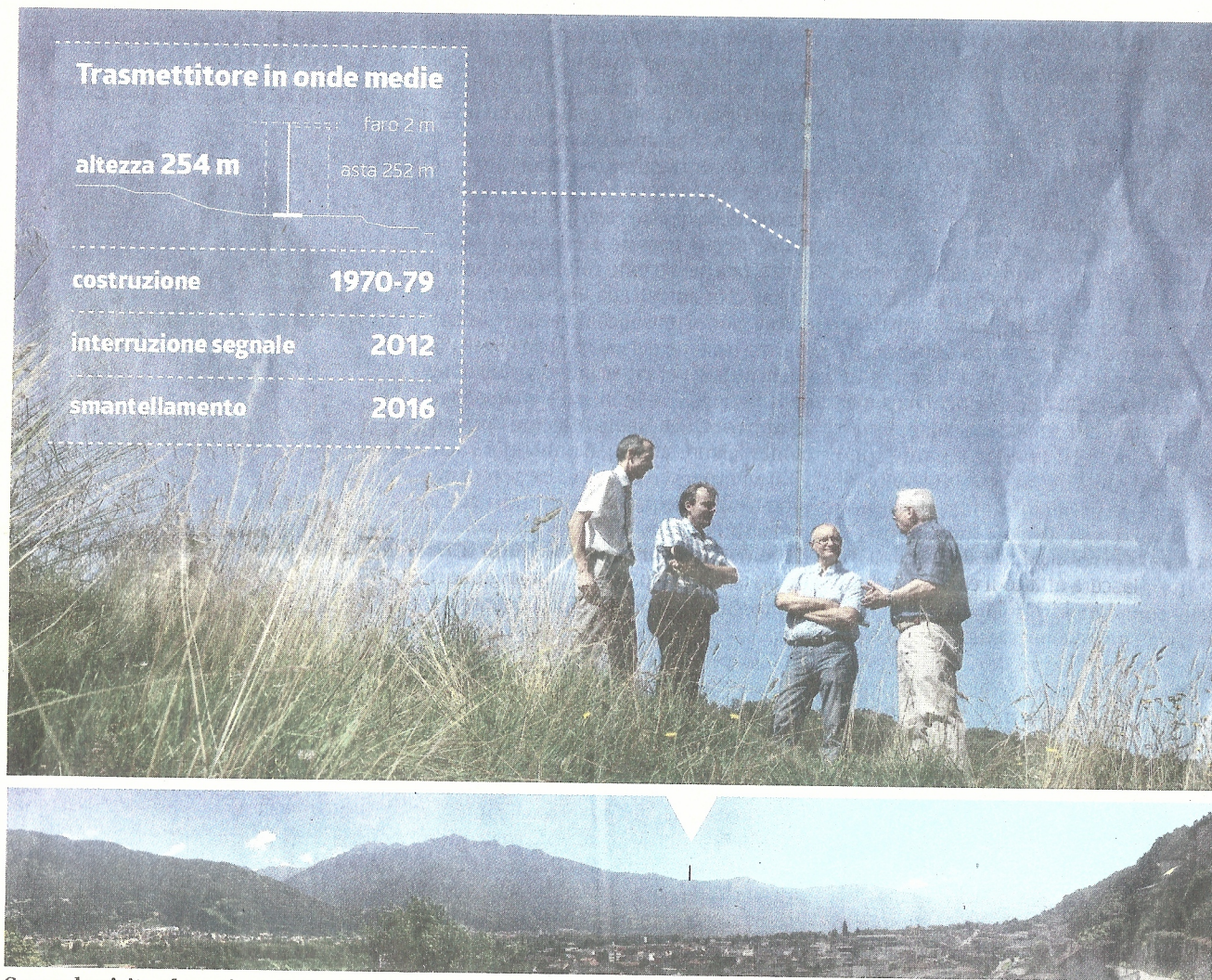
Sopra: la visita al cantiere. Sotto: l'antenna è ben riconoscibile sul filo delle montagne, soprattutto di notte TI-PRESS/LAREGIONE
