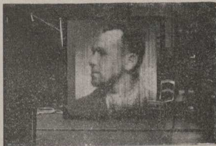
Fig. 17. — Televisione di una immagine sul quadro a lampadine sistema Telefunken-Karolus. L'immagine risulta tanto più perfetta e regolare quanto più lontano sta l'osservatore.
