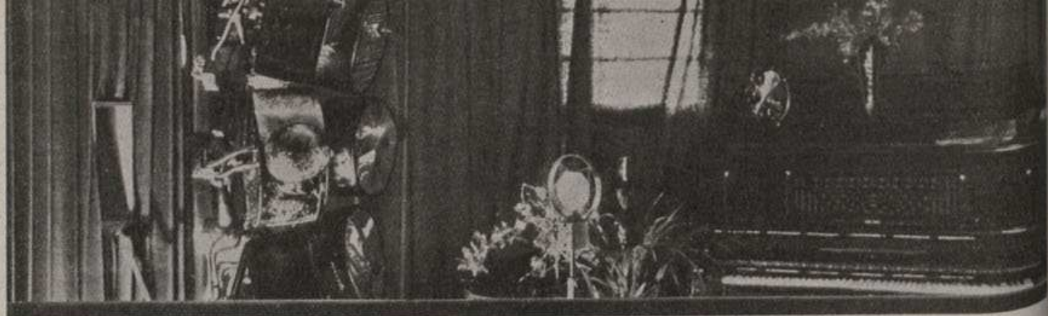
Studio di posa televisivo S.A.F.A.R. per radio trasmissioni sperimentali di televisione diretta con disco di Nipkow a 90 linee e 25 immagini al secondo. (Fiera di Milano, aprile 1932-X).
