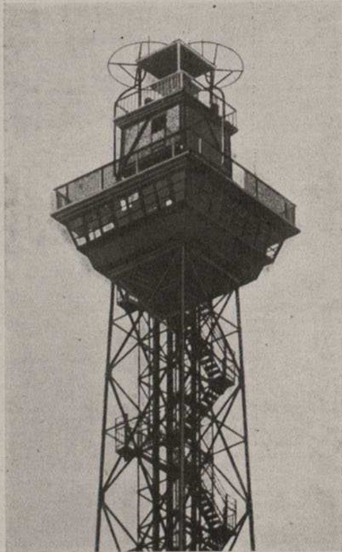
Fig. 1. — Antenne della trasmittente a onde ultracorte per televisione di Witzleben.
